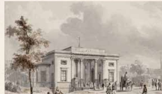
1853– Een stoommachine pompt het eerste leidingwater naar de Amsterdamse Willemspoort.
