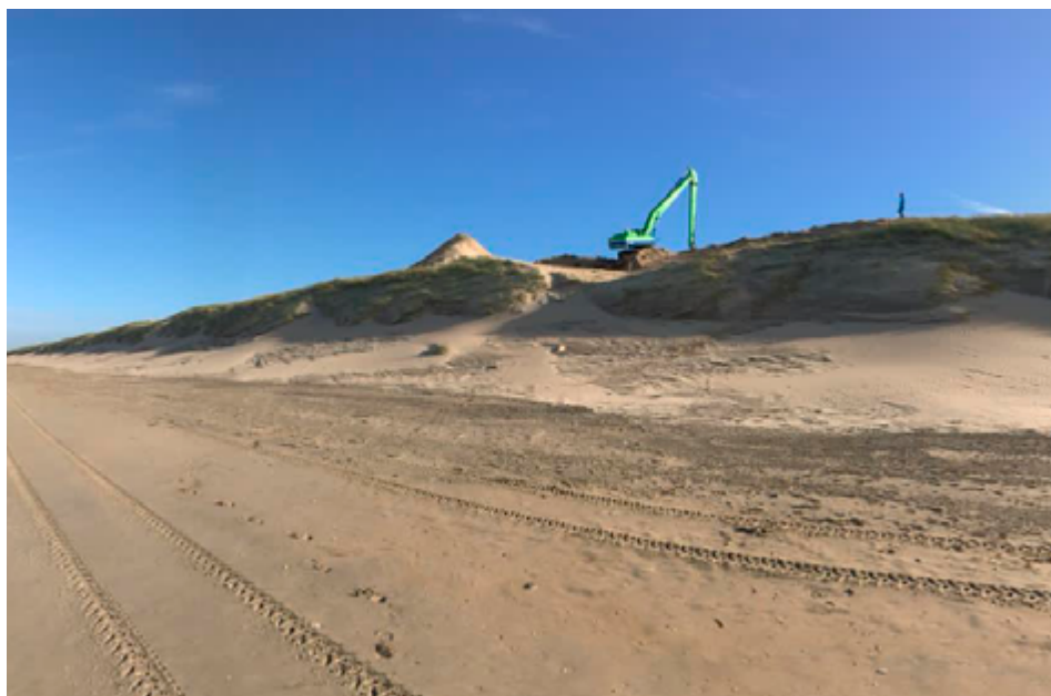
Figuur 2. Het graven van de stuifkuilen
